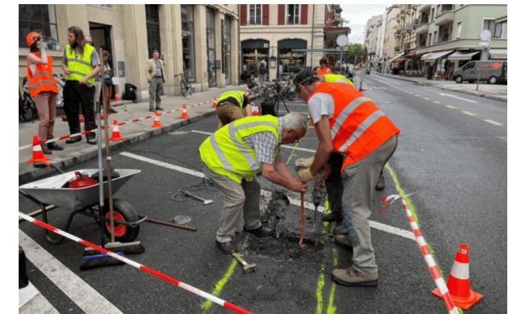
Citoyens en Suisse arrachant du bitume eux-mêmes
