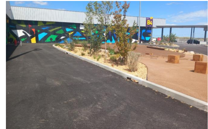
Voirie en pente unique avec bordure avaloir vers la noue
